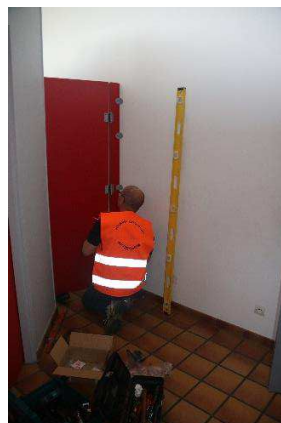
Installation d'une porte battante aux toilettes de la salle des fêtes
