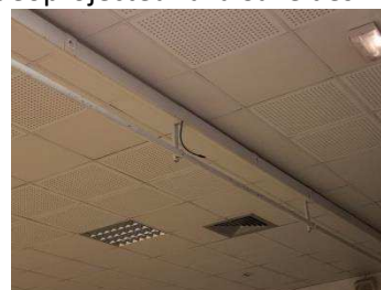
Installation d'un câble HDMI pour vidéoprojecteur à la Salle des Fêtes
