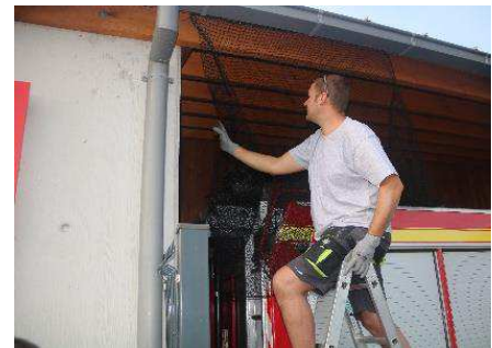
Mise en place d'une protection filet contre les oiseaux au dépôt d'incendie
