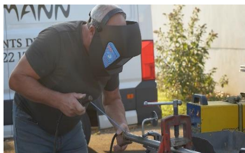
Renforcement de la main courante pour l'accès handicapé de la salle des fêtes
