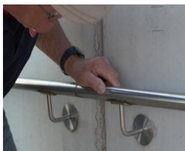
Renforcement de la main courante pour l'accès handicapé de la salle des fêtes
